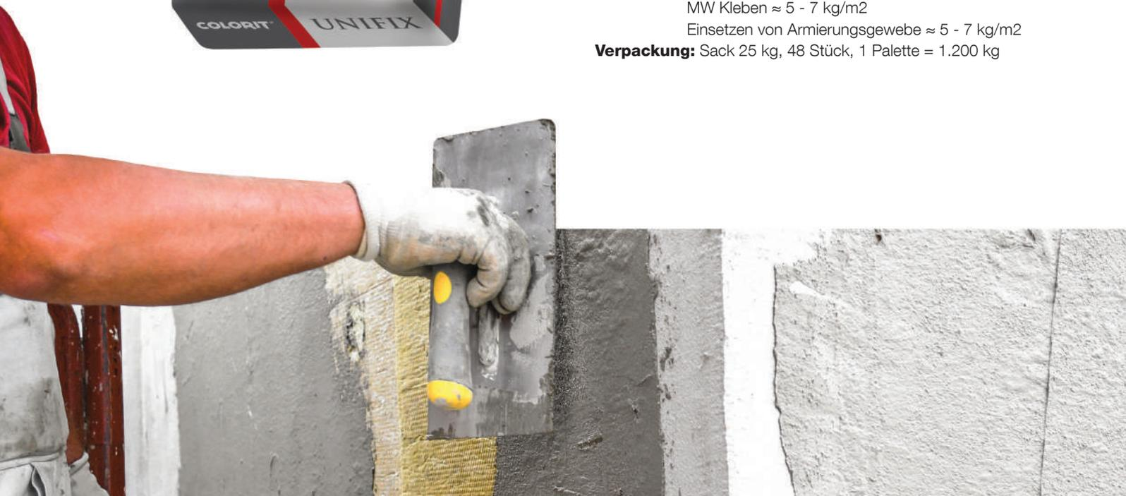
**\*STIROFIX PLUS** - hervorragende Kontrolle der Schichtdicke, leichteres Egalisieren der Oberfläche und Überbrücken kleiner Risse wegen erhöhter Körnung von Füllstoffen und Mikroverstärkungsfasern
